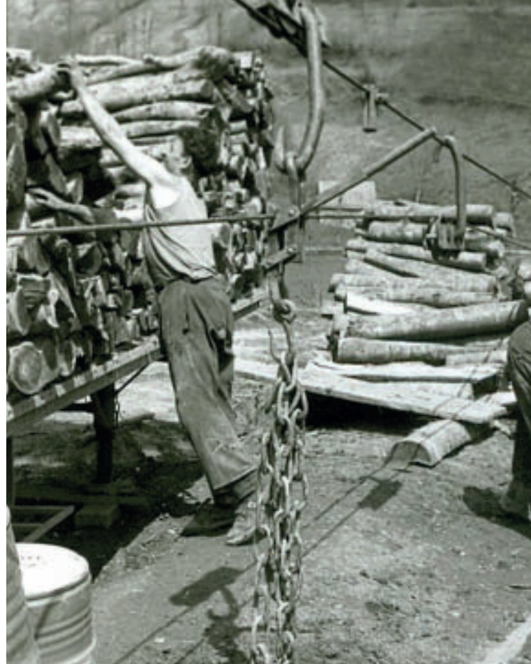
Photo 8 : déchargement du bois
