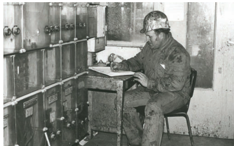
Photo 20 : ancienne cabine conduite évaporation
