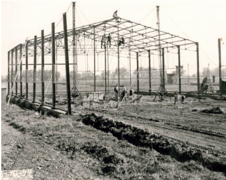
Photo 3 : les débuts de la construction
